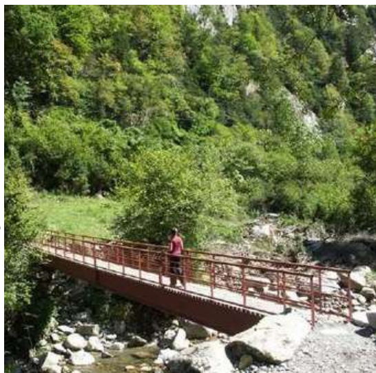
Pont d'Enfer (Hell bridge)
